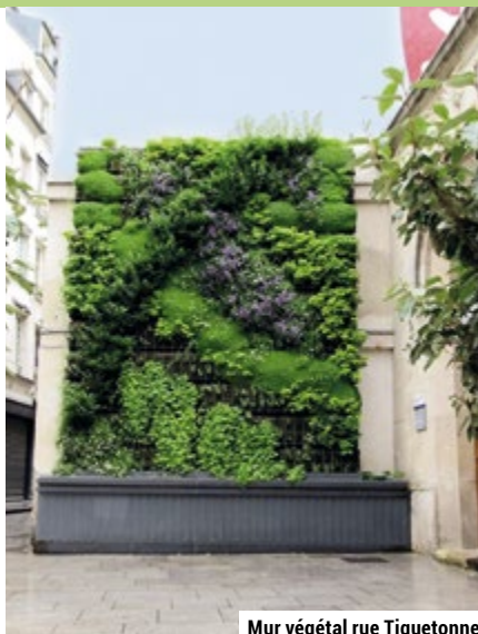
Mur végétal rue Tiquetonne.
